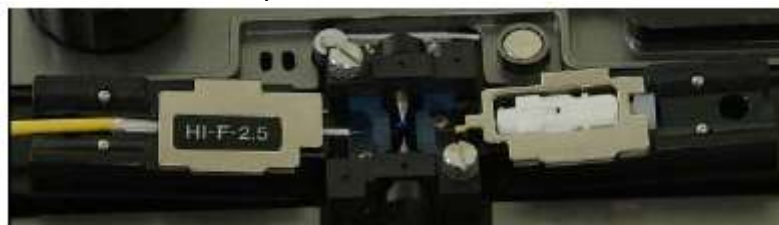
Сварка волокна с разъемом
