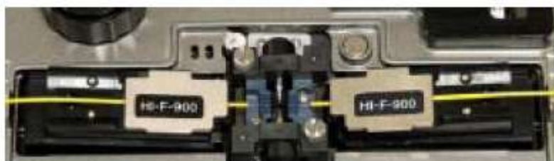
Сварка волокна с волокном
