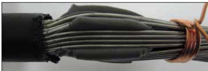
Рисунок 4.35 – Наложение бандажа из проволоки
